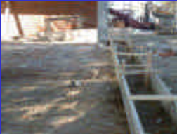
POSICIONADO MALLA ELECTROSOLDADA
