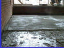
CONTRAPISO NIVELADO PARA RECIBIR TERMINACIÓN
